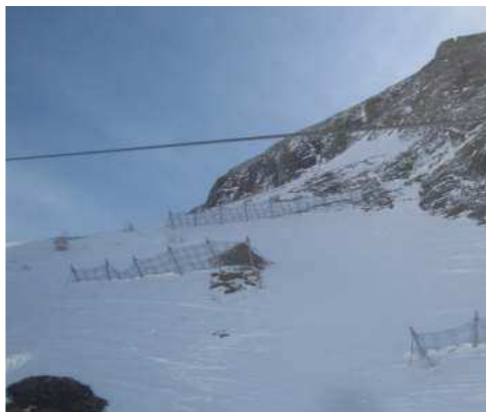
Panoramica del pendio settentrionale del Pizzo del Dosso, con evidenziate le opere di difesa nei confronti dei fenomeni valanghivi (barriere fermavalanghe e cuneo devialavanghe), con particolari.
