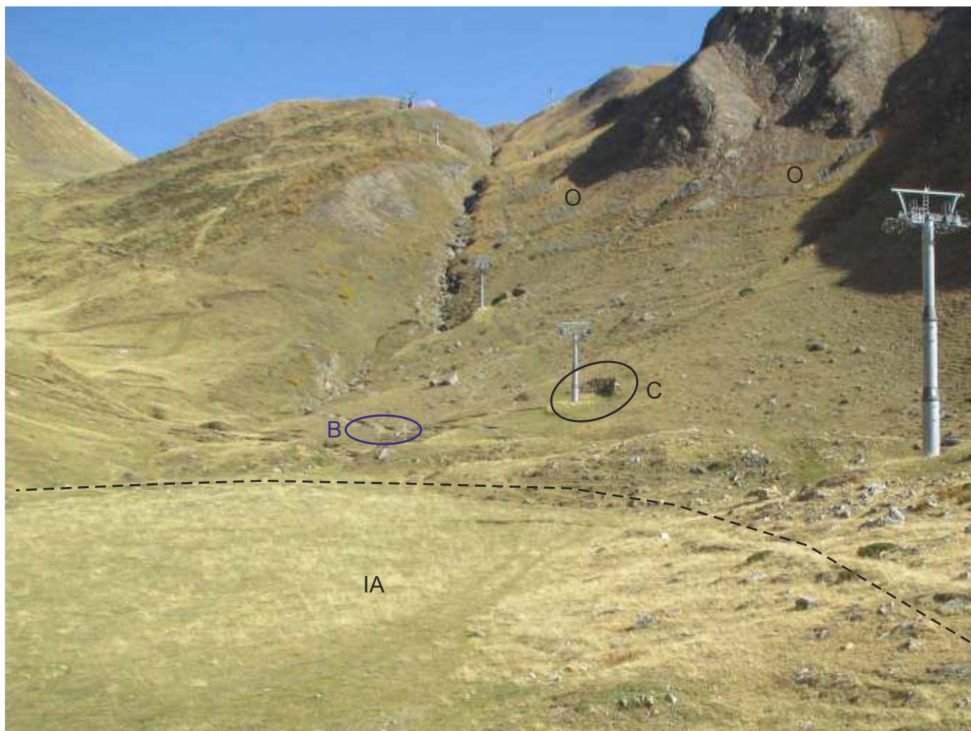
Panoramica da valle dell'area in esame, presa nel periodo estivo, evidenziante il posizionamento delle opere fermaneve (O) nella parte superiore del versante, il pilone di sostegno con cuneo deviavalanghe (C), la posizione indicativa della briglia sul Rio Croso (B) ed il margine di monte dell'invaso artificiale.
