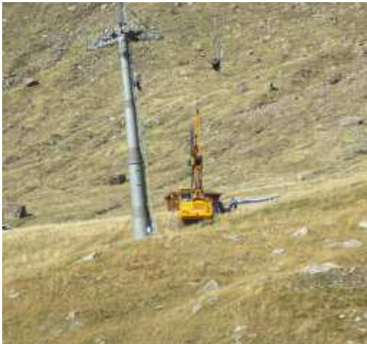
Veduta da Sud della conca morfologica ove verrà realizzato il bacino artificiale per l'innevamento programmato, con esecuzione in corso della perforazione per il posizionamento del piezometro Pz1, a lato ed a monte del bacino
